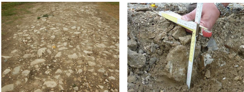
Figure 5 e 6 – Tracce di pavimentazione “Macadam” trovate in prossimità dei tratti di progetto
