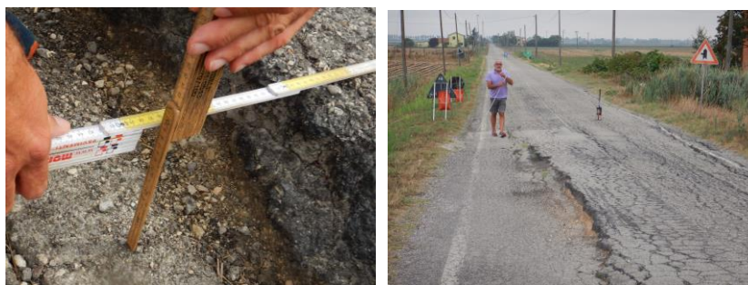
Figure 2 e 3 – Tratti di maggior degrado con cassonetto stradale sfondato
